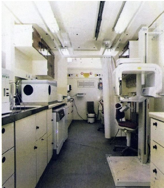
شکل ۲۰-۱ سقف کاذب در یک واحد سیار پزشکی
